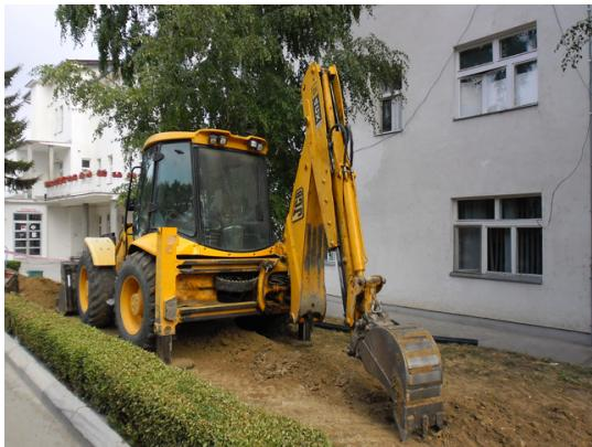
Kompletna rekonstrukcija, zamena dotrajalih vodovodnih cevi i postavljanje nove hidrantne mreže privodi se kraju. Voda sa nove vodovodne mreže već se koristi u zgradama koje su prve priključene na novu mrežu: Odeljenje hirurgije, ginekologije, kožno, interno odeljenje i odeljenje urgentne medicine.
